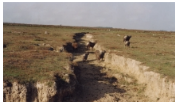
Foto 6. Grieta. Taparas. Paz de Ariporo
